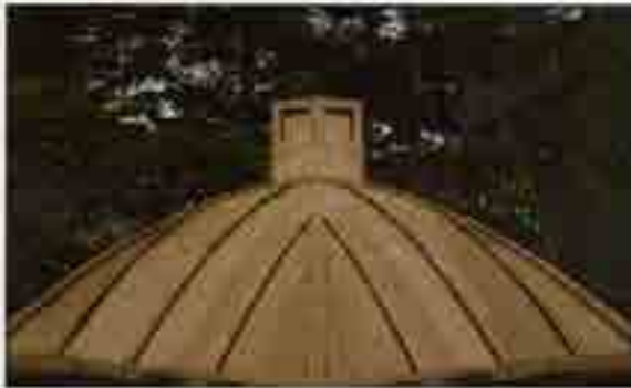
Vista exterior de la cubierta con la cámara.
